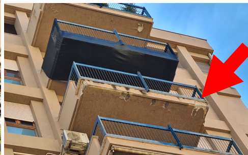
Balcone vano cucina: intradosso soletta oggetto di messa in sicurezza in data 16/04/2024
